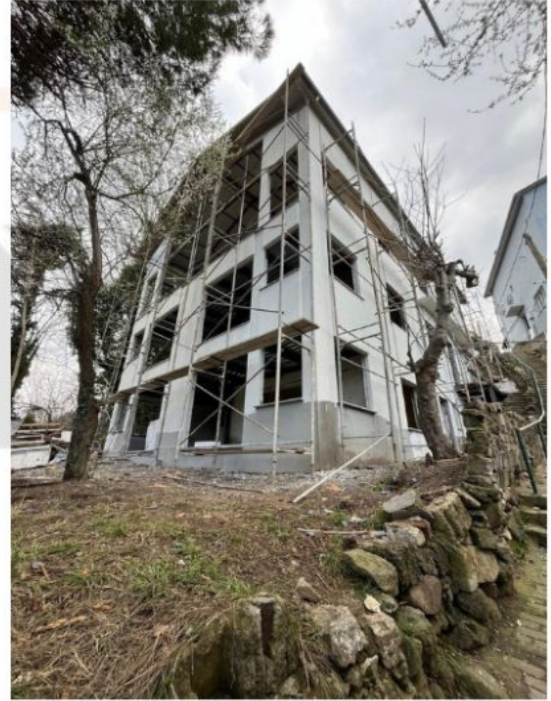
Çelik Konstrüksiyon Bina Yapımı ve Cephe Sistemi Çalışmamız •D.K.Evi,Sarıyer • İstanbul
