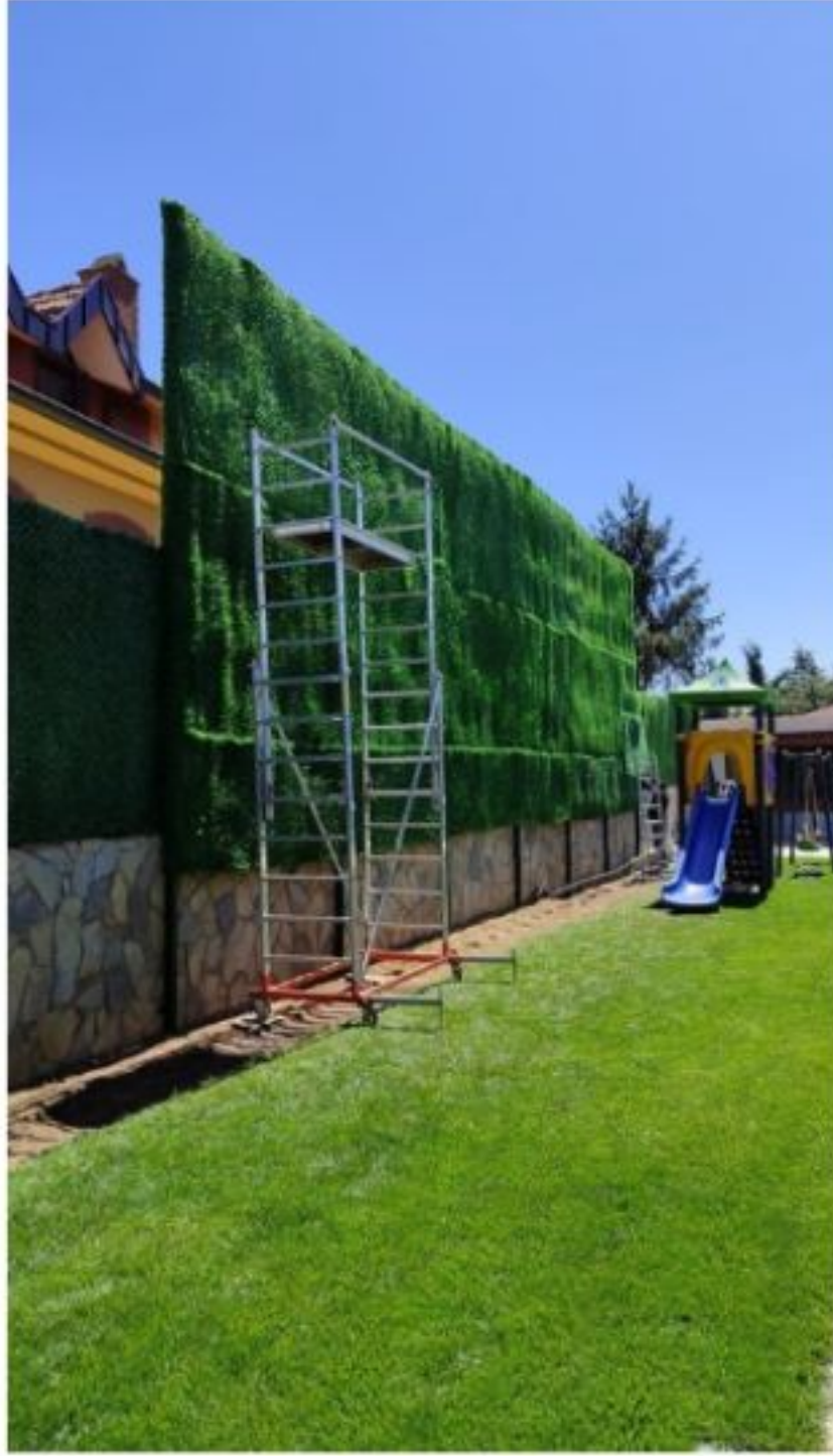
Profil Karkas Üzeri im Görünümlü Panel Kaplama alıřmamız •Y.B.Evi,Kemerburgaz • İstanbul
