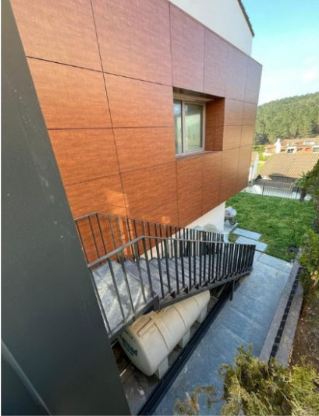
Lama Malzeme Tasarım Korkuluk Çalışmamız •O.G.Evi,Kemer • İstanbul
