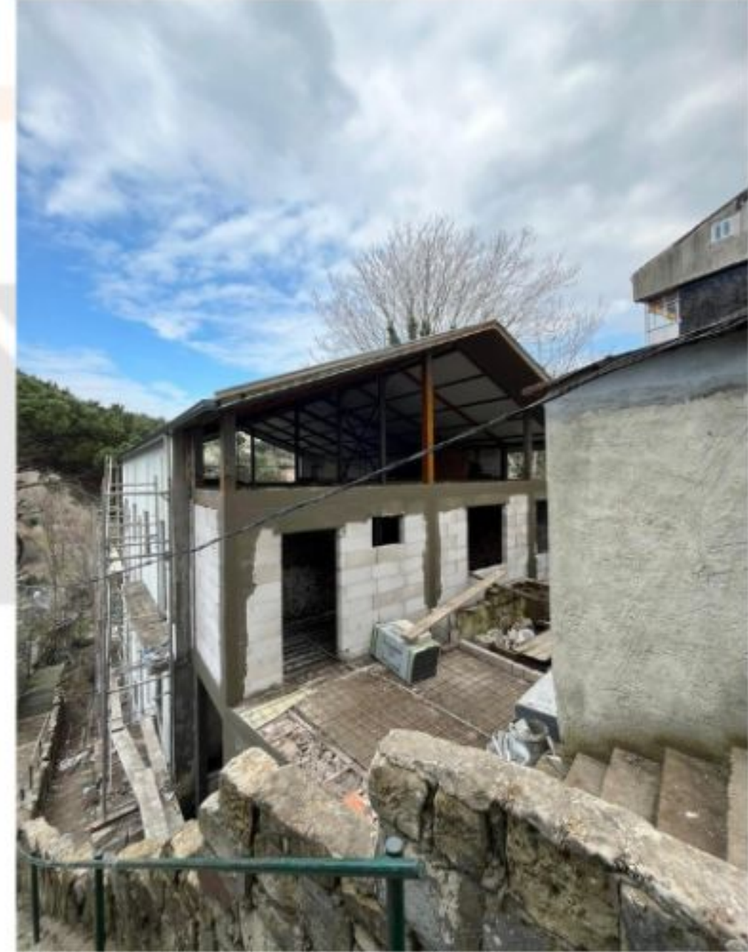
Sandviç Panel Kaplama, Çelik Çatı Sistemi Çalışmamız •D.K.Evi,Sarıyer • İstanbul
