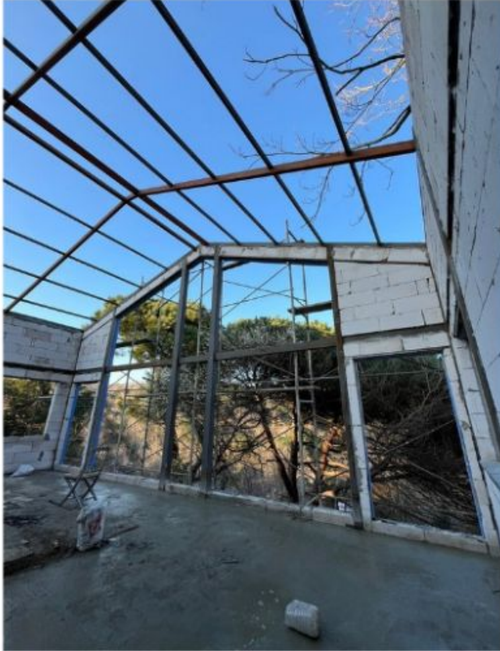
Sandviç Panel Kaplama, Çelik Çatı Sistemi Çalışmamız •D.K.Evi,Sarıyer • İstanbul
