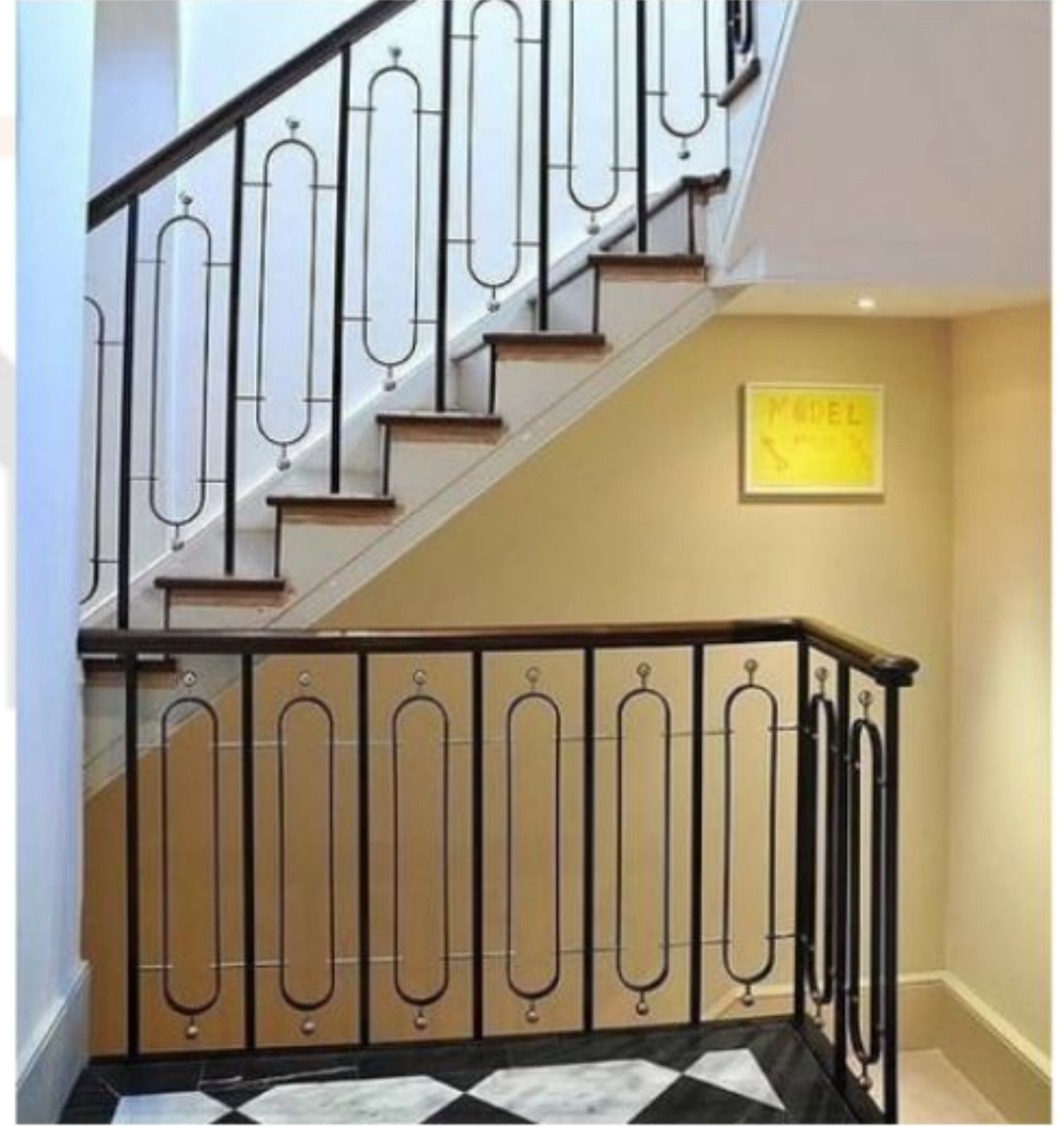
Ahşap Küpeşte Detaylı Korkuluk Çalışmamız •M.T.Evi, Kilyos • İstanbul
