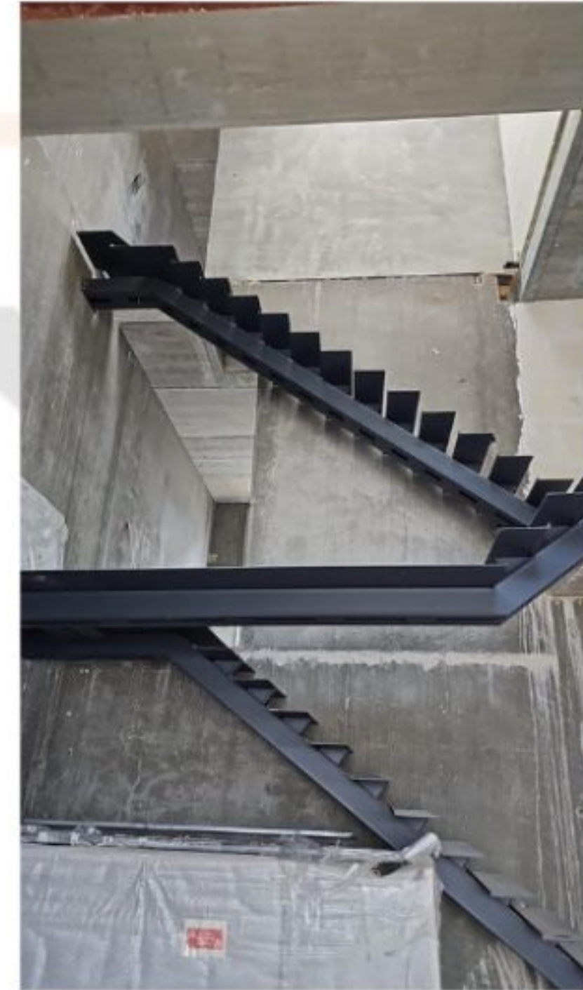
Çelik Konstrüksiyon, Fırın Boyalı, Tek Omurga Sistemli Merdiven Çalışmamız •C.K.Evi,Amsterdam • Hollanda
