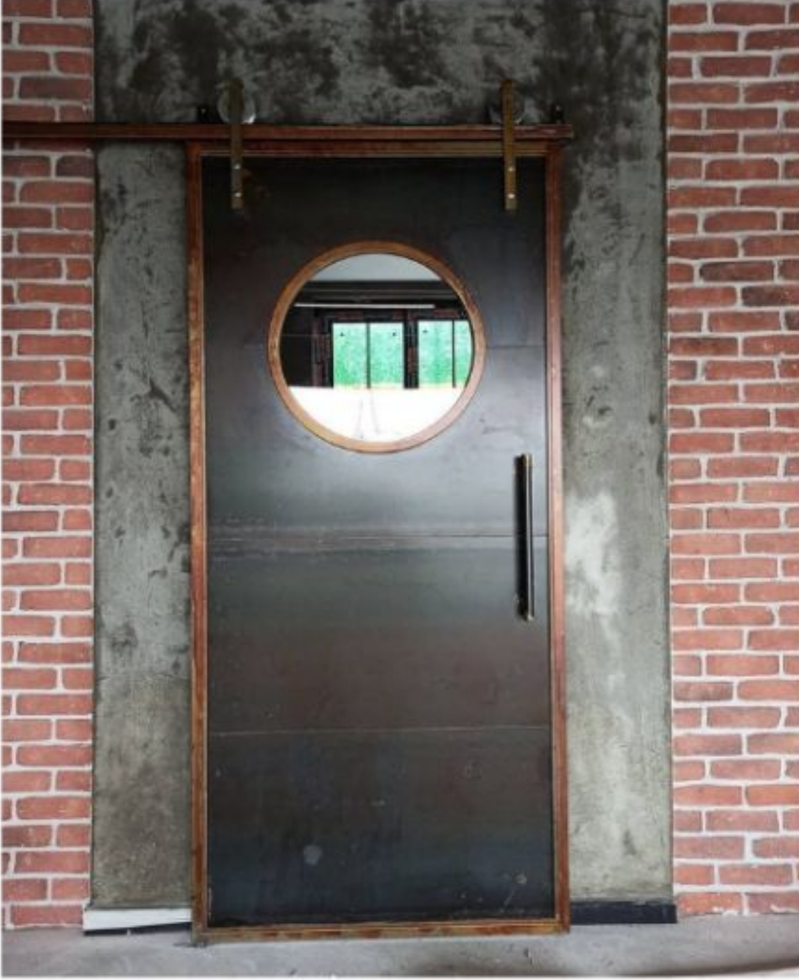
Worn Old Kaplama, Cam Detaylı, Sürgü Sistemli İç Mekan Çalışmamız •Ö.T.EviPelicanHillVillaları • İstanbul
